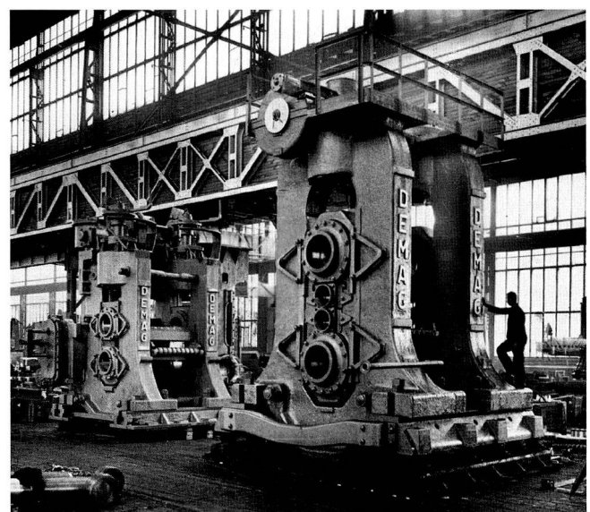
Vor- und Fertiggerüst (rechts) der Warmbreitbandstrasse während der Montage, 1937.
