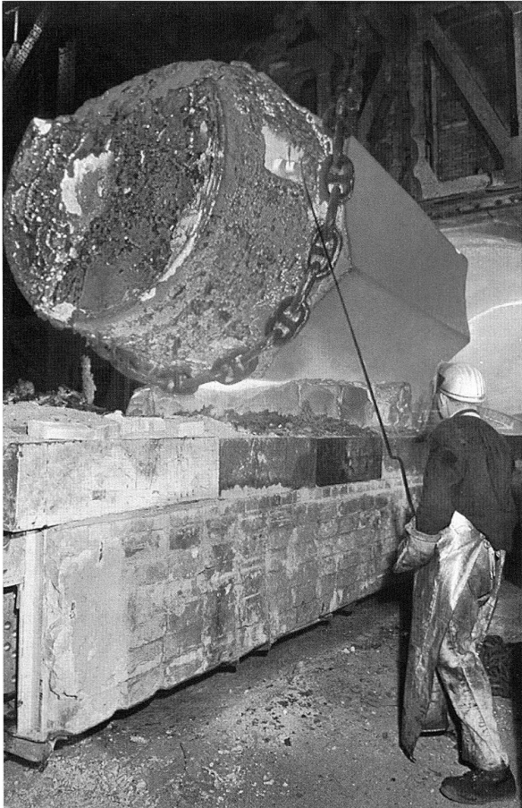
Mit 200 Tonnen konnte die Henrichshütte 1958 die schwersten Blöcke der BRD schmieden, 1950er-Jahre (Ruhrstahl AG: Erzeugnisse der Henrichshütte Hattingen, Ruhr, undatiert, S. 14).
