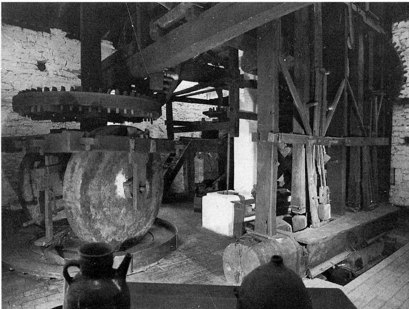
*Bild 3: Ölmühle in Lemgo-Brake. Bei dieser Mühlen-technik war nur der Lagerzapfen der Welle aus Eisen. Diese «hölzerne Maschine» produzierte bis 1925.*
