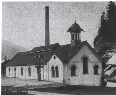
Les frères Troller ont bâti la centrale électrique de Thorenberg en 1886: en produisant du courant à haute tension, on a limité les pertes lors de l'acheminement; l'industrie n'était plus confinée sur les rives des rivières. La réglementation d'utilisation du courant et les prescriptions de sécurité ont abouti à la loi sur les installations électriques (LIE) adoptée en juin 1902.
