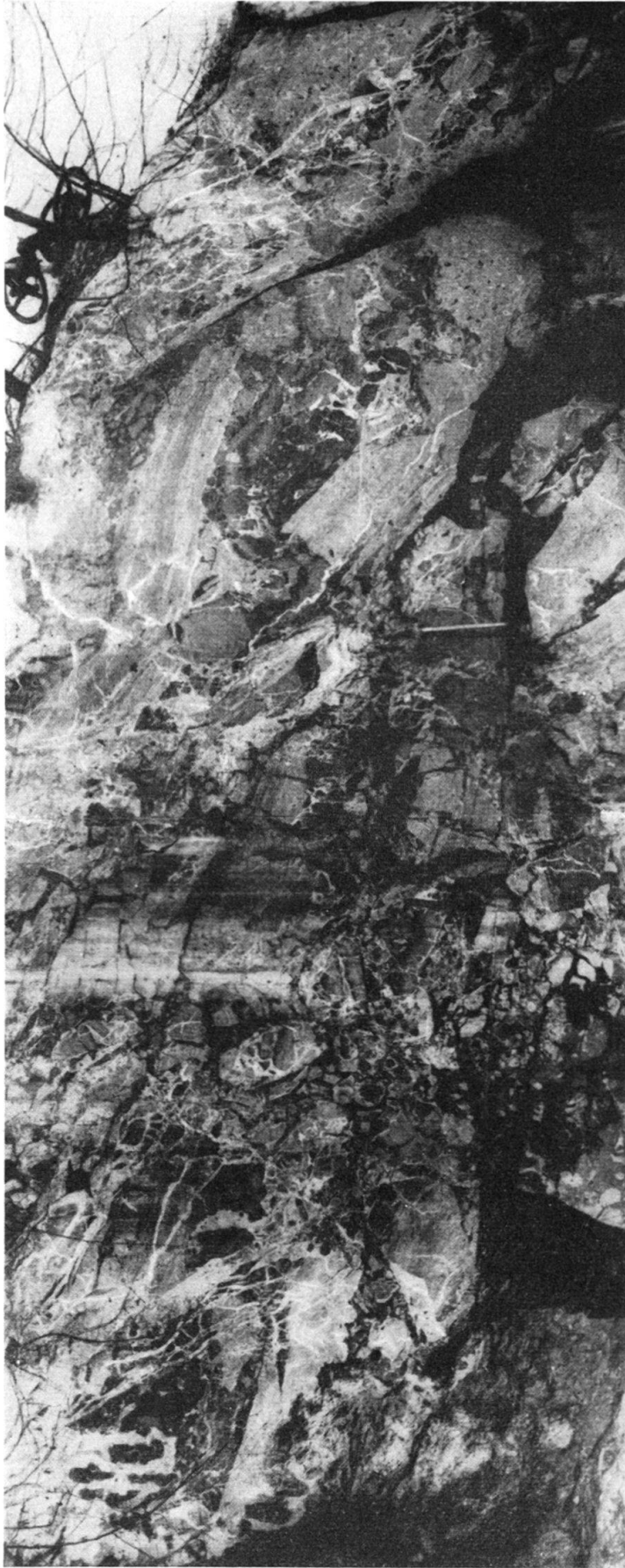
Fig. 36. Cave d'Arzo, «Marmorzimmer-Steinbruch» (Taf. IV, D/4, N). Die plangesägte E-Wand gewährt besonders schön Einblick in das Grossgefüge der Macchia vecchia. Rechts ganze Schichtpakete von Hauptdolomit. Links von der Mitte komplexe, mehrphasige Trümmer in Domérian-Mergelkalk. Hammer (rechts von der Mitte) 50 cm lang.
