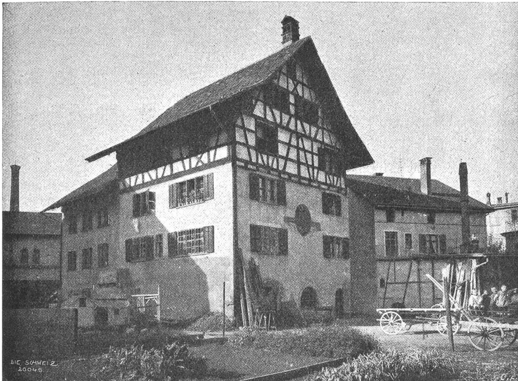
Die zum Abbruch bestimmte „Blumenbleiche“ in Winterthur. Phot. S. Säggli, Winterthur.
