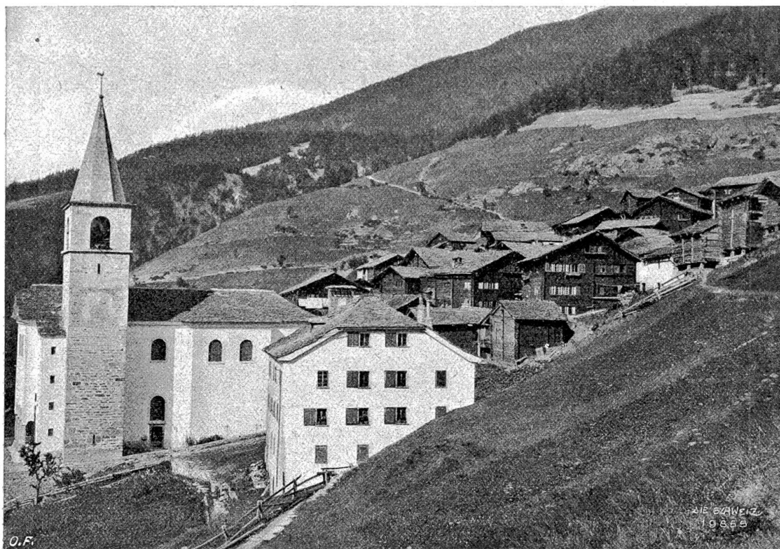
Das Heidenwasser Abb. 1. Visperterminen, das Herrenviertel mit Kirche und Pfarrhaus.
