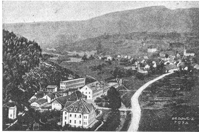
Mümliswil mit der durch Explosion zerstörten Kammfabrik Walter-Obrecht.
