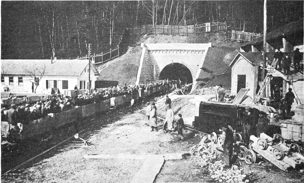
Vom Bau des neuen Hauenstein-Bafis-Tunnels. Das südliche Portal bei Olten mit einfahrendem Arbeiterzug. Phot. Anton Krenn, Zürich.
