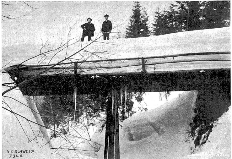
Verfallene Brücke am Speer. Phot. A. Düggelin.
