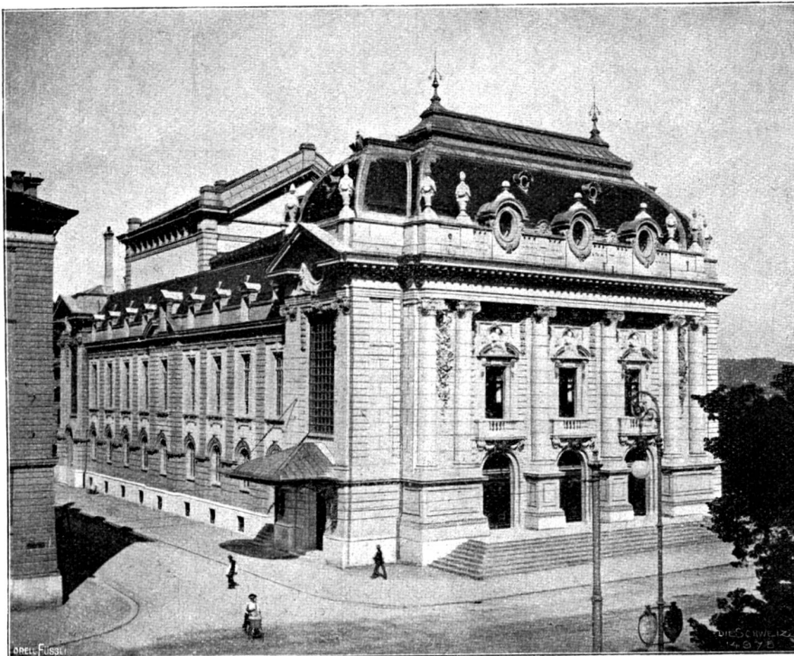
Das neue Stadttheater in Bern (Phot. A. Krenn, Zürich).
