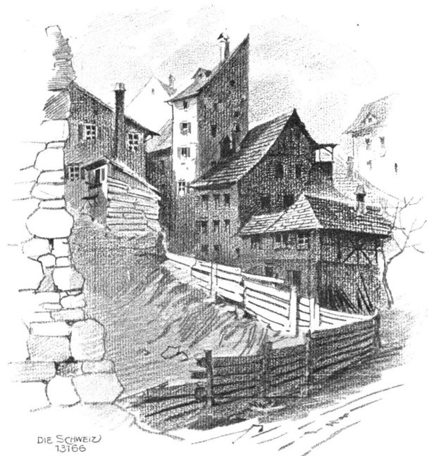
Das Trillengäßlein in Basel während des Abbruchs. Originalzeichnung von J. Billeter.
