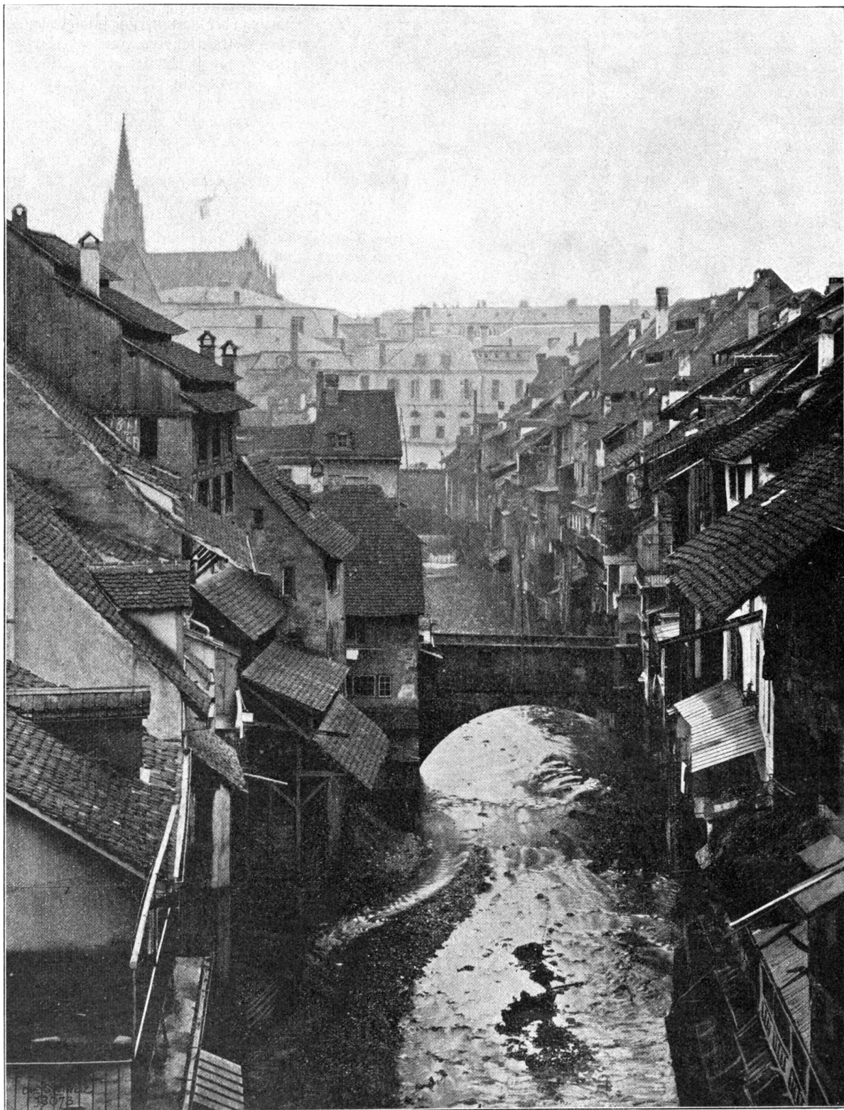
Der abgeriffene Stadtteil an der Birsig zwischen dem Postgebäude und dem Barfüßerplatz in Basel (Falknerstraße).
