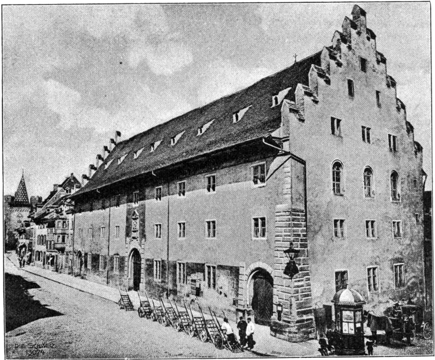
Das Kornhaus in Basel vor dem Abbruch (1890). (Im Hintergrund das Spalenthor).
