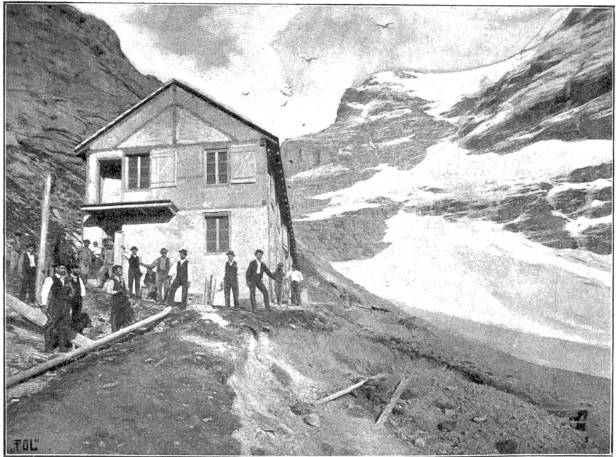
Fig. 3 Jungfraubahn: Obere Hauptbaracke beim Eigertunnel. Phot. Gabler, Interlaken (28. Okt. 1897).
