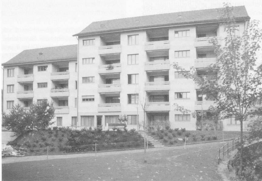
Genossenschaftliche Alterswohnungen in Wattwil: In engem Kontakt mit dem nahe gelegenen Alters- und Pflegeheim. Foto zVg
