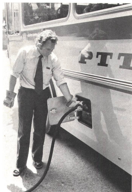
Fig. 13 Auftanken mit Flüssiggas — Remplissage du réservoir avec du gaz liquide
