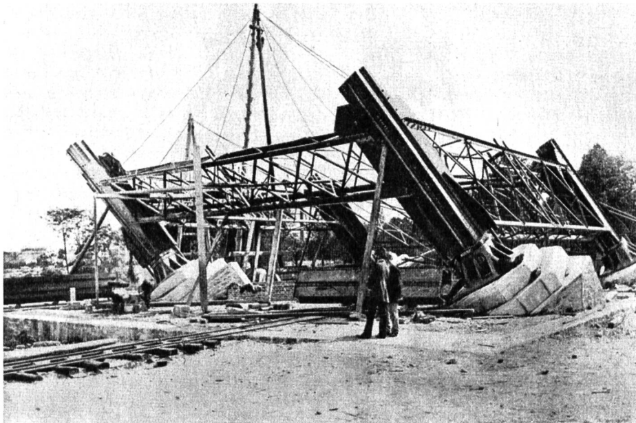
Fig. 2. Commencement du montage métallique.
