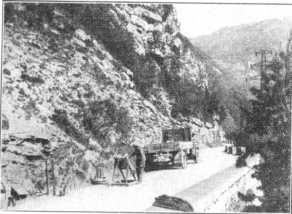
Fig. 17. Einzug eines Kabels mit dem Spill des Kraftwagens auf der Axenstrasse.
