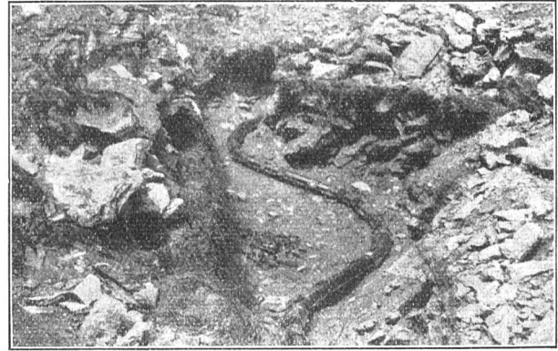
Fig. 21. Ausgleichsbogen vor einer Bachkreuzung.
