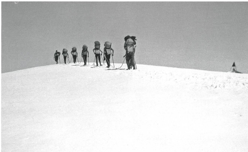
Abb. 70: Eine technische Aufnahme mit künstlerischen Qualitäten: Trägerkolonne mit Zement und Sand im Aufstieg zum Triangulationspunkt 1. Ordnung Titlis für die Reparatur des Pfeilers und der Pyramide. Aufnahme von Ingenieur Werner Lang, 1923. Filmnegativ 12x9 cm (swisstopo, Bildsammlung, technische Aufnahme 2321).
