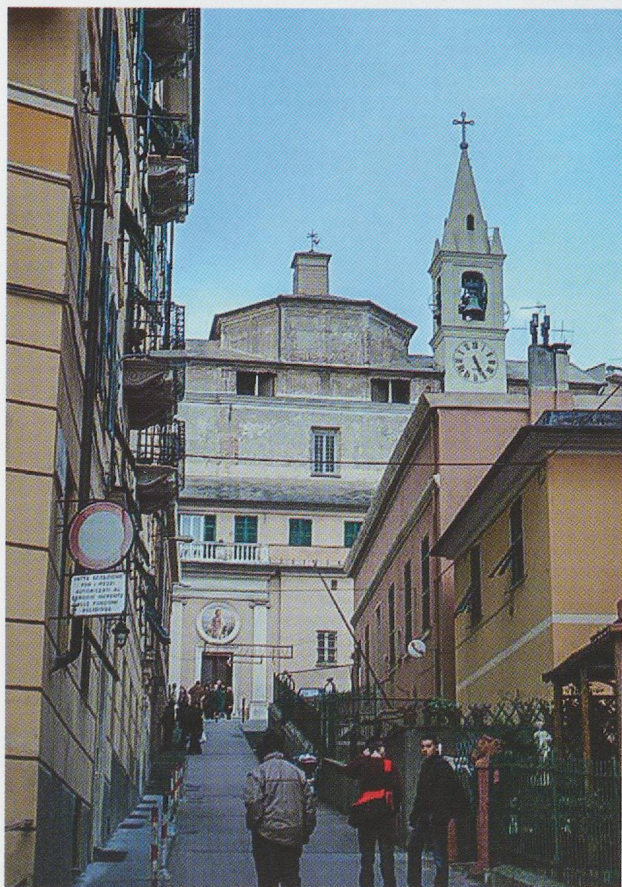
La chiesa della Certosa, fianco Sud-Occidentale.
