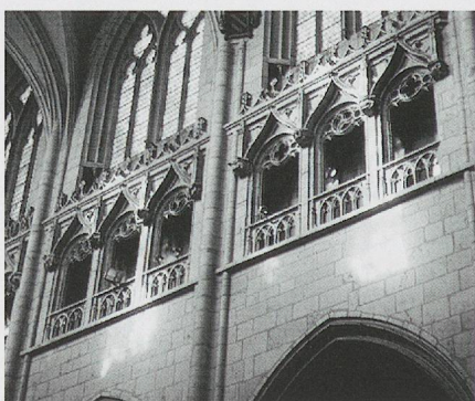
Fig. 1047. L'église Saint-Nizier à Lyon. Le triforium de la nef avec remplages suspendus et coursière haute à festonnage «tolédan» (photo MG, 2001). Voir détail: vignette p. 613.
