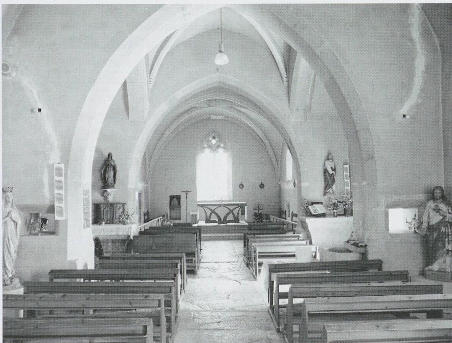
Fig. 262. L'église Saint-André de Montanges. Vue de l'intérieur, de la nef vers le chœur: nef, premier arc triomphal avec ses deux lunettes, croisée surélevée, second arc triomphal et chœur (photo MG, 2011).
