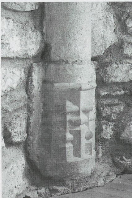
Fig. 255. L'église Saint-Nicolas de Villes en Michaille. Base de la colonne engagée du nord-est du chœur (photo MG, 2012). Voir fig. 723.
