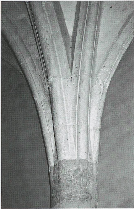
Fig. 266. L'église Saint-Michel de Lompnieu en Valromey. Retombée des ogives en tores sans listel sur une colonne engagée (photo MG, 1980).
