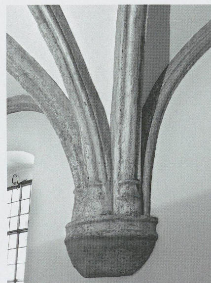
Fig. 290. L'église paroissiale d'Allaman VD. La chapelle seigneuriale des Russin, entre 1468 et 1481: retombées médianes des voûtes d'ogives sur des bases reçues par un large culot (photo MG, 2009).
