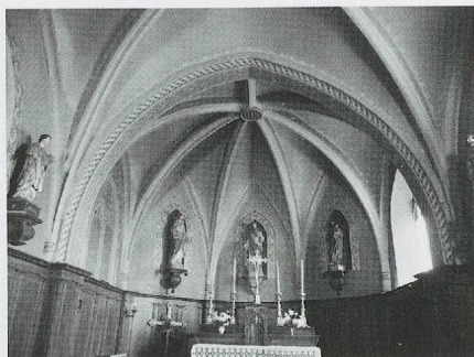
Fig. 271. L'église Saint-Romain d'Hotonnes en Valromey. Les voûtes du chœur avec la lierne et les baies seulement au sud (photo MG, 2010).
