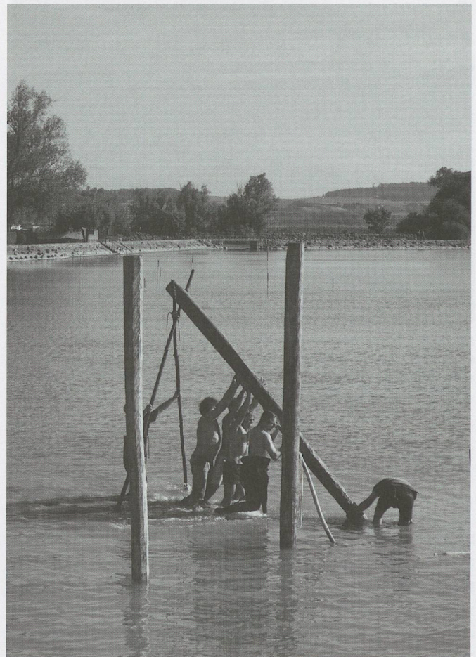
Fig. 318 : Expérimentation de l'enfoncement in situ des pieux en chêne d'une pile du pont Vouga à La Tène par l'archéologie cantonale neuchâteloise et le Laténium, en septembre 2007.
