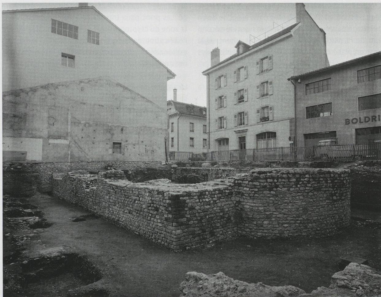
Fig. 53. Nyon, Musée romain, fouilles 1974. Vue sud-ouest des murs de la nef de la seconde basilique (M 2006, M 2008 et M 2009).
