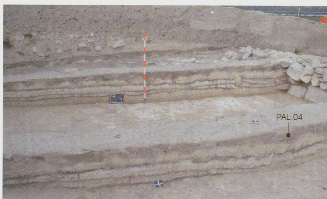
Fig. 91 — Zone 2. Sédimentation de type marécage formée par effet de barrage du mur de pierres sèches (à droite). Les liserés sombres visibles en coupe correspondent à la « roselière » supérieure. Le niveau humifère au sommet des bermes témoins correspond au paléosol du Moyen Âge (PAL.04). Vue depuis l'est.
