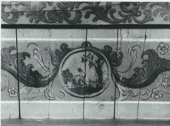
1036. Yverdon, la rue du Lac 26, détail du plafond peint de la cage d'escalier, vers 1700. (R. Gindroz)
