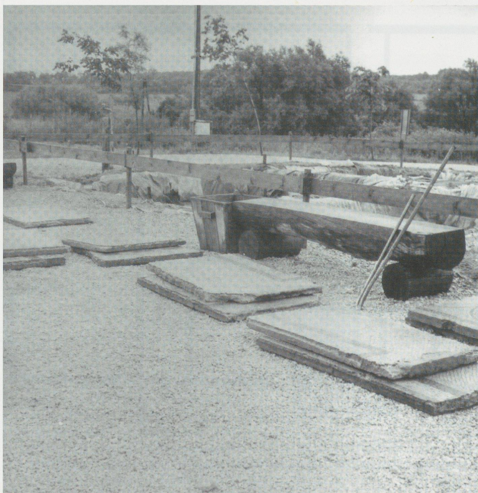
Abb. 4. In Beton eingebettete Mosaiktafeln aus dem Raum Nr. 8 vor der Neulegung
