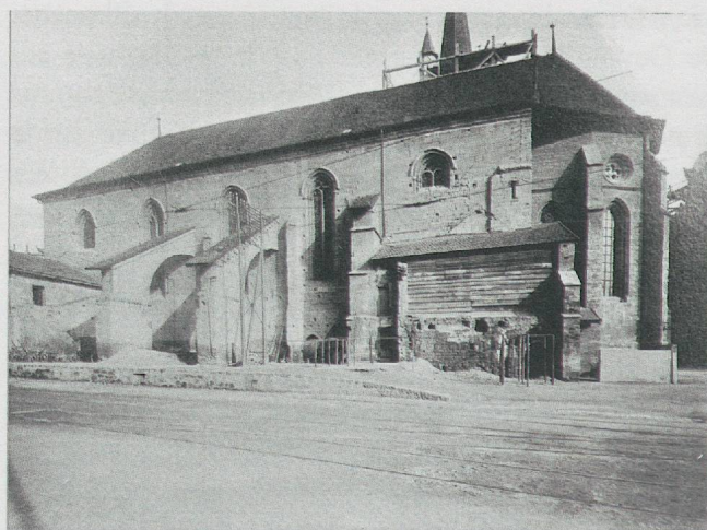
Fig. 68 Edmond Bornand Face sud du temple, après la démolition des hangars des Postes et avant la construction du kiosque des tramways, 1896. La façade sud est dégagée, à l'exception de la remise adossée à l'angle sud-ouest du temple, abritant les dépendances du poste de police et la sacristie contre la travée orientale de la nef, fermée au bas par le mur nord de l'ancienne salle capitulaire. Ces éléments disparaîtront en 1901. (MHL: Collections photographiques)
