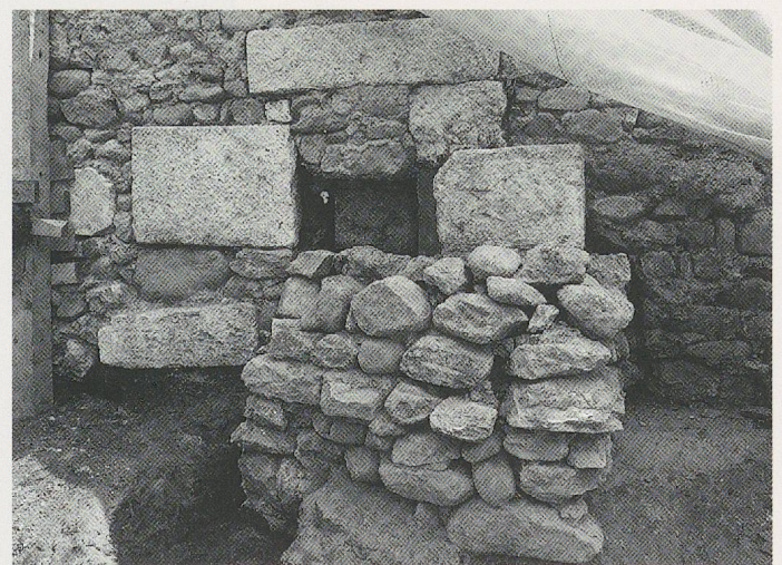
Fig. 17. Le contrefort II 6 , réutilisé en fondation de la chantepleure à l'étape VII.
