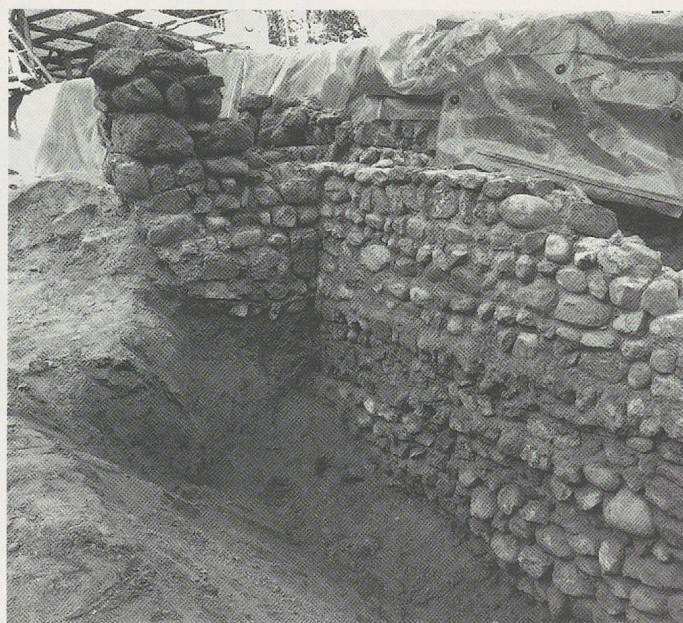
Fig. 12. Terrasse ouest, le parement du mur II 1 .
