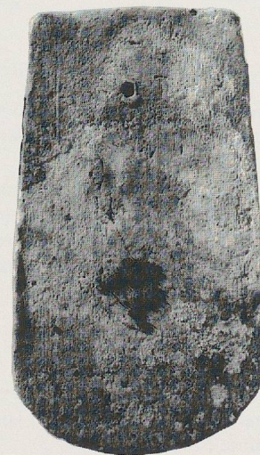
Fig. 111. Tuile de clocher gironnée, façonnée «à la française» et à découpe en anse de panier. Probablement fin XV e siècle (Coppet, maison du «Vieux-Couvent»).
