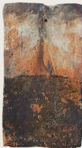
Fig. 65a-b. Tuiles trouvées sur la tour-lanterne de la Cathédrale de Lausanne et décorées d'un vernis vert foncé sans engobe (a) ou vert sur engobe clair (b).
