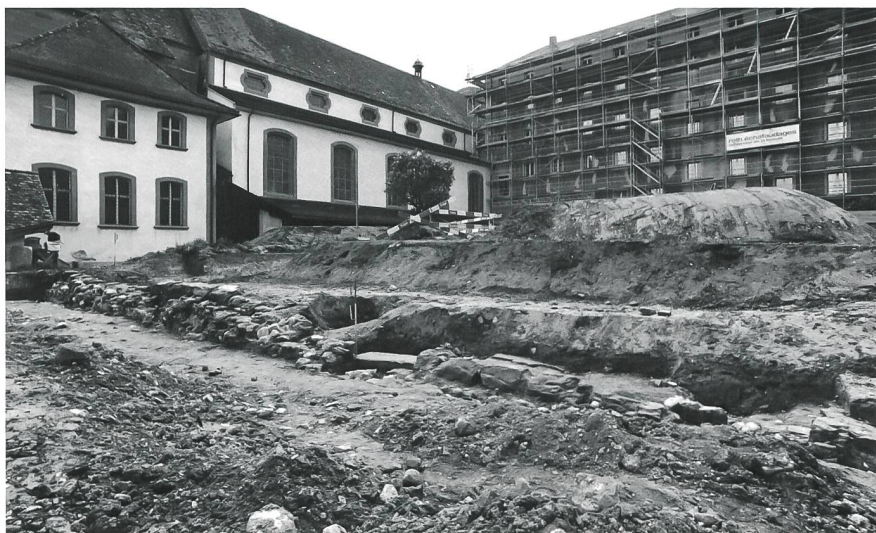
Fig. 8 Fribourg/Couvent des Cordeliers. Vestiges du mur est de l'aile orientale du couvent, dès 1256; à l'arrière-plan, l'église et le couvent de 1712-1725, surélevé en 1938
