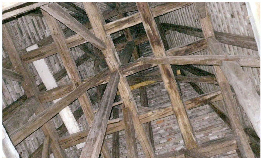
Abb. 8 Dachwerk des Turmes
