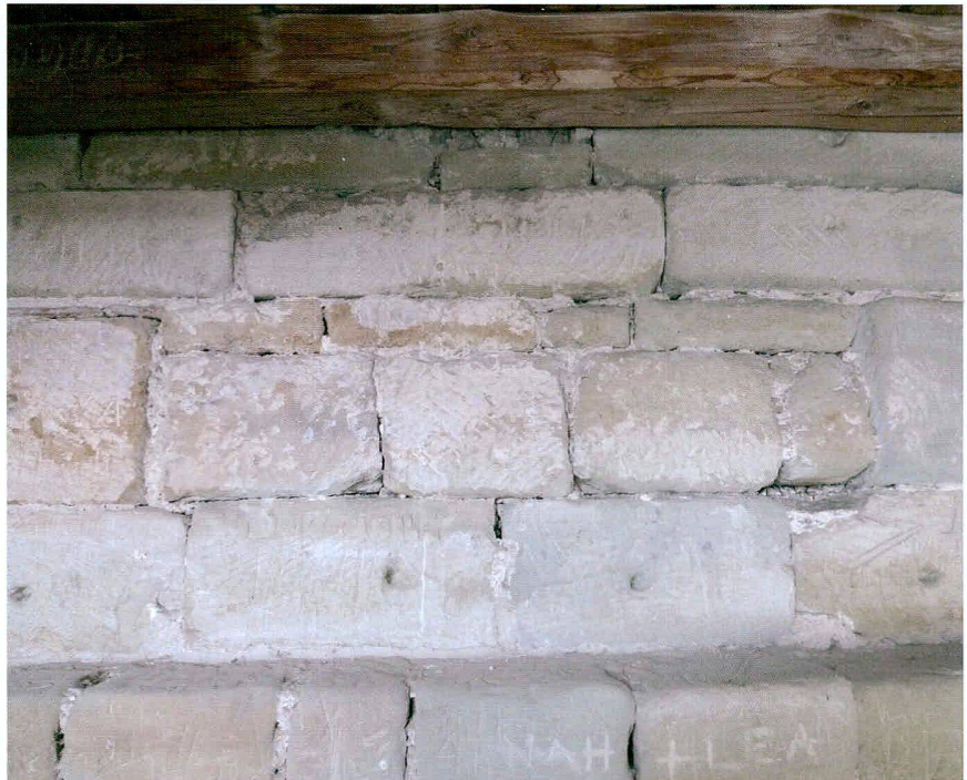
Abb. 7 Oberer Bereich der südlichen Turminnenseite mit Mauerrücksprung und zugesetzter Öffnung
