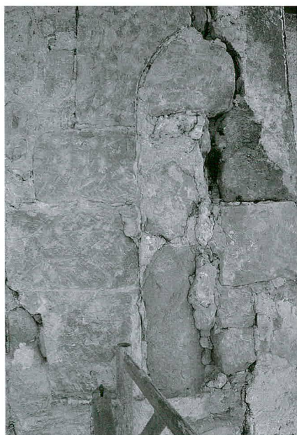
Fig. 11 Fribourg/Stalden 16. Restes de la fenêtre primitive du deuxième étage (première moitié du XIII e siècle)
