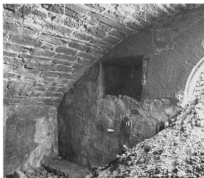
Fig. 9 Fribourg/Ferme des Pillettes. Mur d'entrée de la cave
