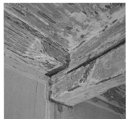
Abb. 15 Murten/Hauptgasse 19. Profile der Holzdecke im ersten Obergeschoss
