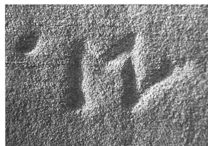
Fig. 18 Romont/Collégiale. Marque de François Moschoz sur le mur sud de la troisième travée de la nef
