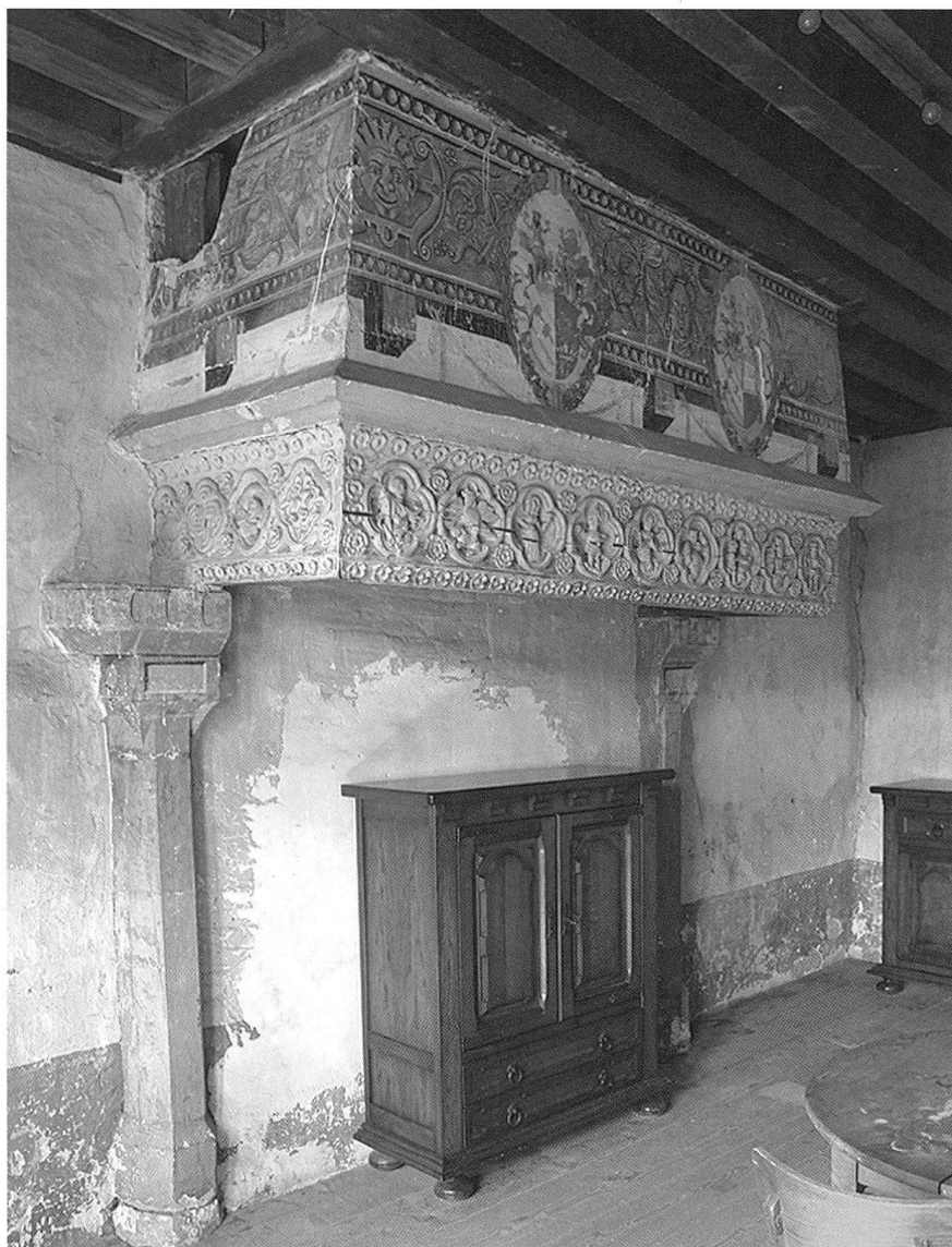
Fig. 19 Rue/Maison de Prez-Maillardoz. Cheminée de la grande salle du deuxième étage
