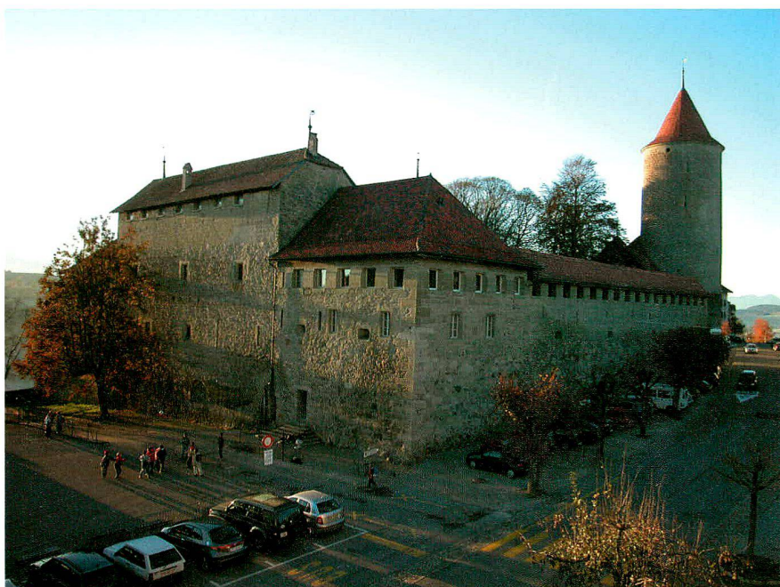
Fig. 18 Romont. Vue générale du château depuis le nord-ouest avec l'aile nord des années 1240, à gauche
