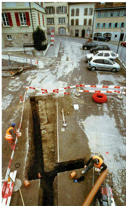
Fig. 19 Rue/Place de la Foire. Vue vers l'est. A l'ouest, le mur observé à l'extérieur du fossé défensif
