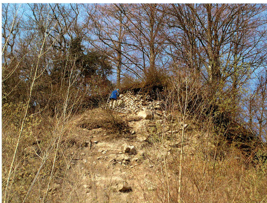
Fig. 17 Pont-la-Ville/Bertigny. La construction carrée menacée par l'érosion dans la gravière désaffectée
