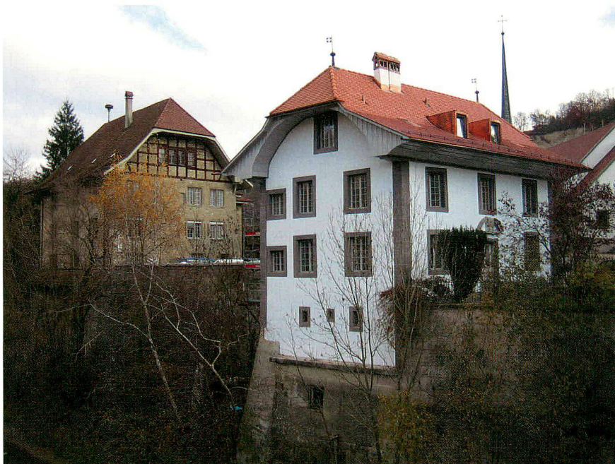
Abb. 9 Freiburg/Johanniterkomturei. Ansicht von Nordwesten, Zustand nach der Instandsetzung (November 2006)
