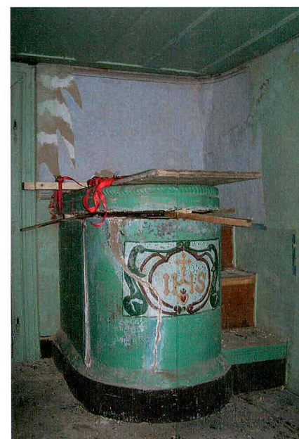
Fig. 14 Gruyères/Bourg 36. Poêle du deuxième niveau en cours de démontage
