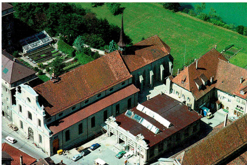
Fig. / Abb. 1 Vue aérienne de l'église des Cordeliers avec son chœur gothique et sa nef de 1745 Luftbild der Franziskanerkirche mit dem gotischen Chor und dem Langhaus von 1745
