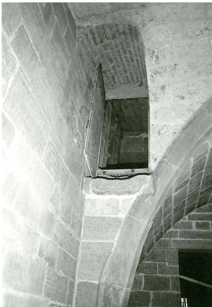
Fig. / Abb. 32 Porte d'accès au jubé, ménagée au XVI e -XVII e siècle dans la voûte de la sacristie gothique Die im 16.-17. Jahrhundert angelegte Tür zum Lettner im Gewölbe der gotischen Sakristei
