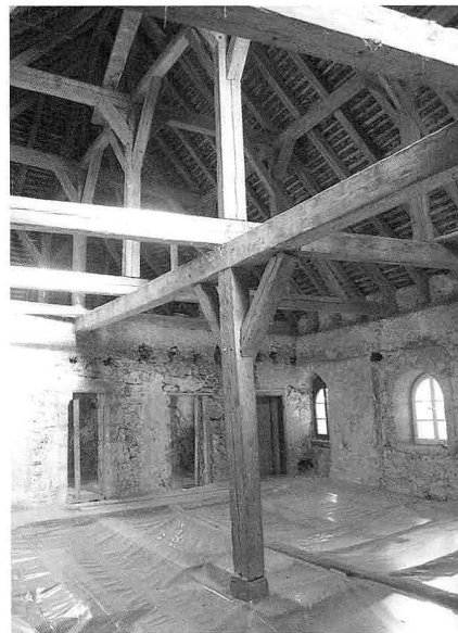
Fig. 8 Gruyères/Château. Charpente de l'ancienne conciergerie datant de 1563/64
