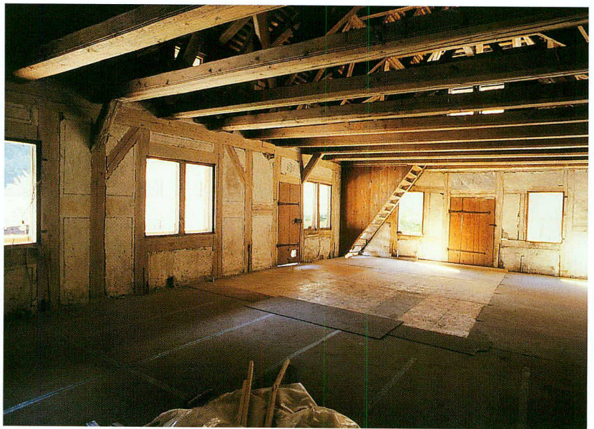
Fig. 14 Grenier, grande salle du premier étage en cours de restauration
