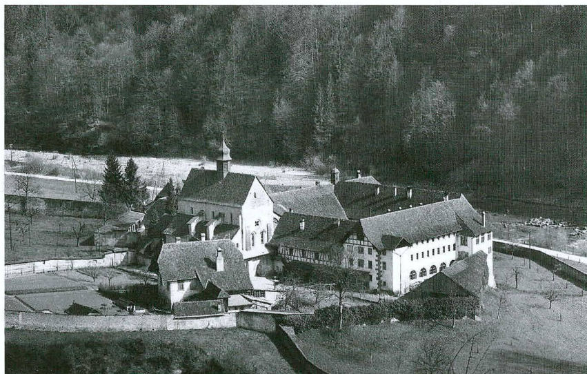
Fig. 1 Vue générale du monastère
