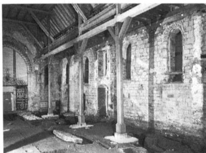
Fig. 18 Mur sud de la nef
