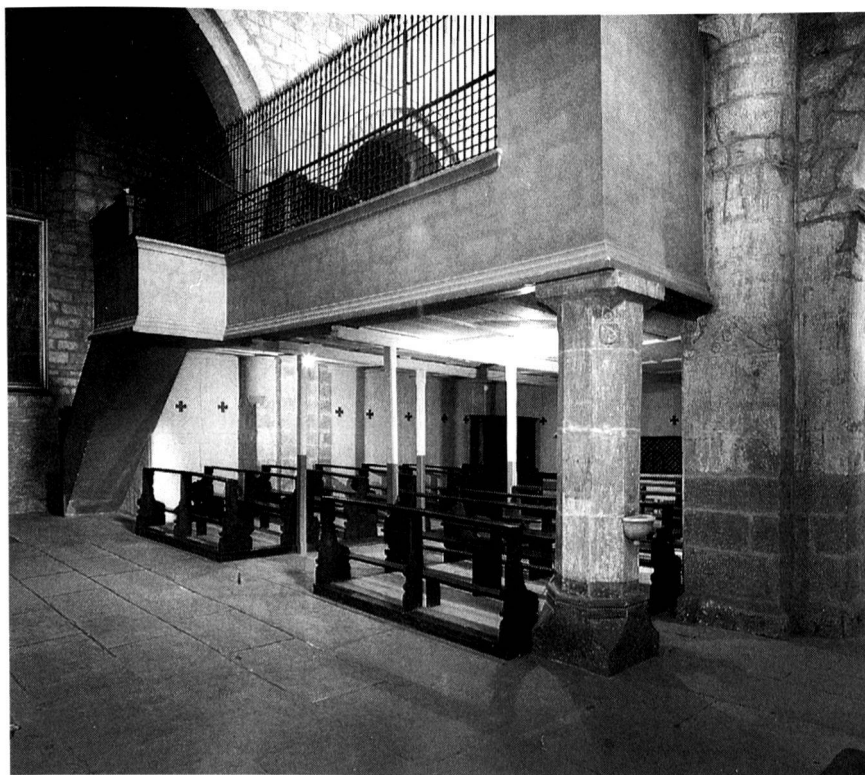
Fig. 53 La Maigrauge. Tribune-choeur des moniales érigée en 1610 dans la nef de l'église et démolie vers 1980. L'espace au-dessous de cette tribune était réservé aux laïcs, avec lesquels les moniales ne pouvaient entrer en contact. Une tribune similaire a occupé de 1618 à 1726 les deux tiers de la nef de la Fille-Dieu (Photo: L. Hilber, Fribourg)
