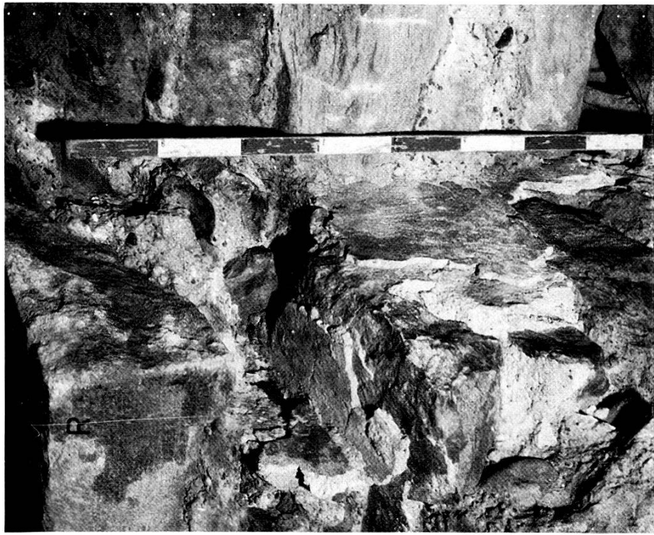
Tafel 7 B. Kryptenzugang. Vgl. zu dieser Detailaufnahme die Abbildung 11 mit ausführlicher Beschreibung; Links oben der Eckquader R des Kastenlettners. Links vom Maßstab, gegen den Betrachter zu streichend, die Reste der Mauermange samt Verputz, welche die Kryptentreppe be- gleitete. Von rechts her die spätere Vermauerung. Beim Loch unten Durchblick in die Krypta. Photo: M. Rudin.
