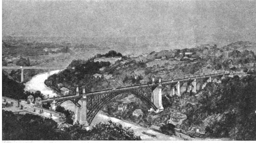
Die Kornhausbrücke nach dem in Aquarell ausgeführten Plan, mit deren Bau im Herbst 1895 begonnen wurde
