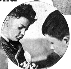
Ausschneiden einer Flügelrippe aus Sperrholz
