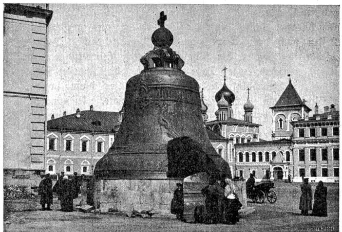
Die Zaringlocke, 1735 unter der Zarin Anna gegossen, 8 Meter hoch, 20 Meter umfassend, über 2000 Doppelzentner schwer, ist aber nie geläutet worden, sondern liegt auf offenem Platze mit ausgebrochenem Stück auf ihrem Steinsockel.
