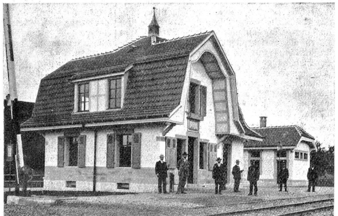
Das neue Stationsgebäude in Rüti bei Büren.
