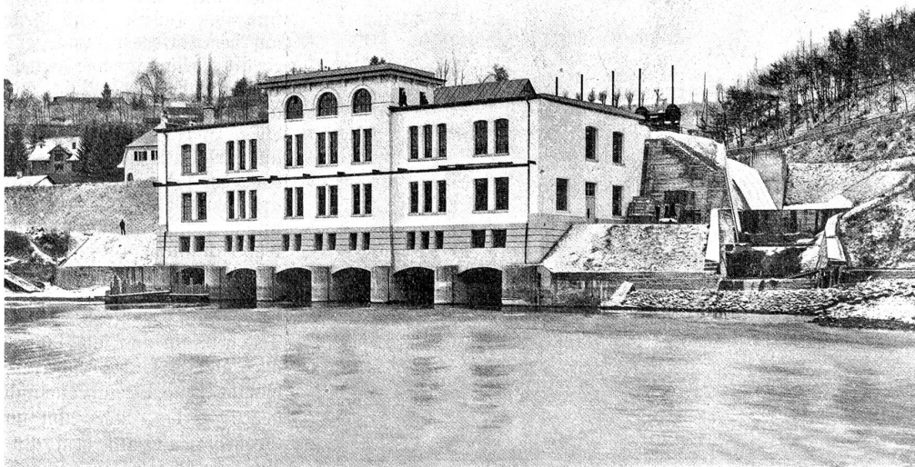
Das Elektrizitätswerk in der Felsenau bei Bern.
