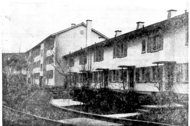
Schöne Partie aus der bekannten ASIG-Siedlung in Schwamendingen, Zürich 11. Diese landschaftlich wohlige Genossenschaftskolonie wurde im Rohbau aus Durisol-Mauersteinen erstellt.
