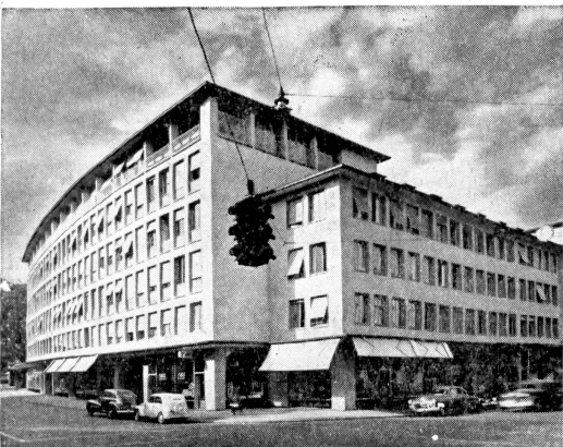
Talhof, Ecke Talstraße-Pelikanstraße, Zürich
