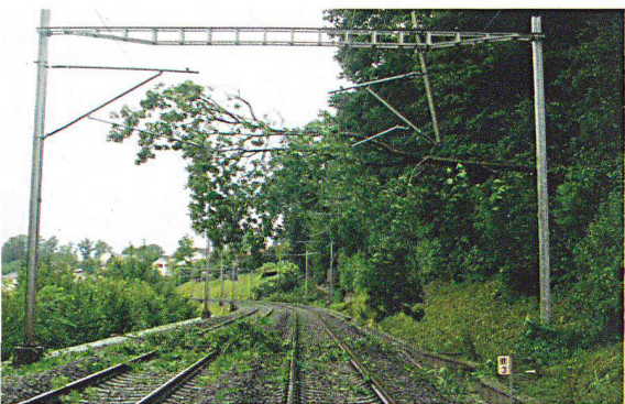
Umgestürzte Bäume blockieren die Strecke zwischen Freiburg und Flamatt im Sommer 2007.
