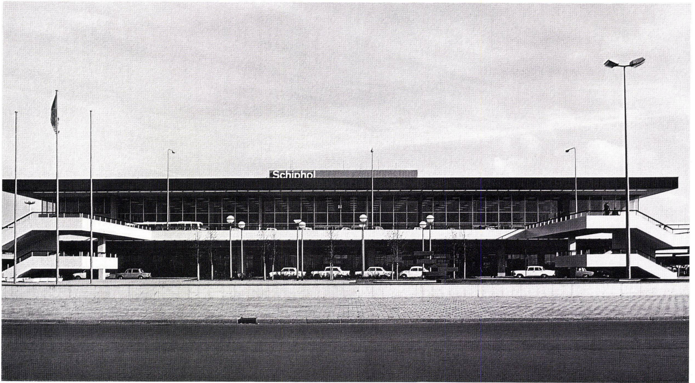
14 Westfassade vom Hauptgebäude. Façade ouest du bâtiment principal. West face of main building.
