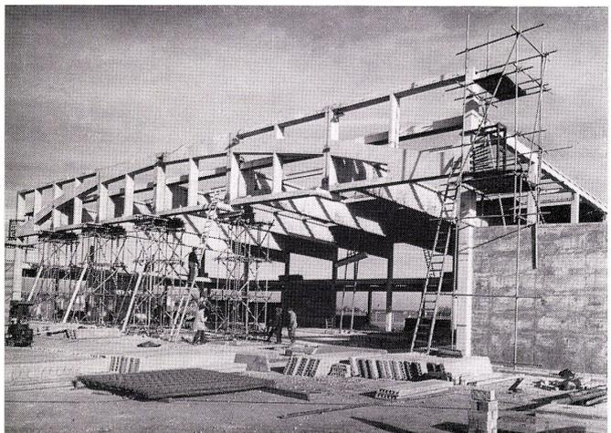
3.23 Das Dach zu den Skelettkonstruktionen
