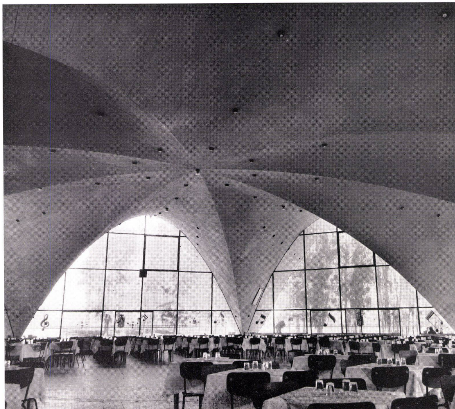
3 Detail der Auflagerung. Um die Schale vom Boden zu lösen, wurde sie auf einen Sporn aufgesetzt. Das Regenwasser wird durch ein außen sichtbares Rohr abgeleitet. Die Lösung scheint gestalterisch wenig glücklich zu sein. Détail de l'appui. Afin de détacher le voile du sol, il est placé sur un éperon. Les eaux de pluie s'écoulent dans
